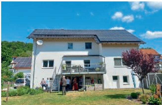
Das sanierte Haus der Familie Kohl ist für die Energiewende gerüstet. Außen zu sehen sind eine PV-Anlage auf dem Dach und eine Wallbox für das E-Auto. Vor dem Haus steht unter der Eingangstreppe die Außeneinheit der Vaillant-Wärmepumpe.
