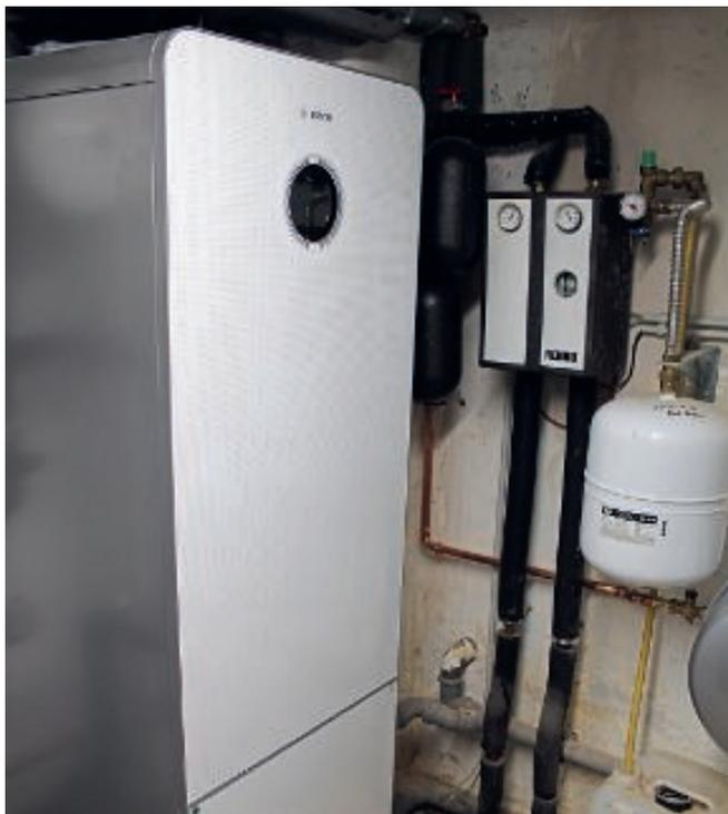
Die Inneneinheit als All-In-One-Tower-Variante verfügt die Compress 5800i AW über einen integrierten 180-l-Warmwasser- und einen 16-l-Pufferspeicher. Sie läuft mit dem alternativen Kältemittel Propan.
