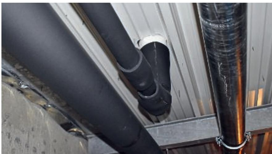
Die Dämmung der Rohre verhindert Kondensat und schützt die Produkte so vor Feuchteschäden. Gedämmt wurde individuell vor Ort. Links die bereits gedämmte Hauptentwässerung, rechts die noch ungedämmte Notentwässerung.
