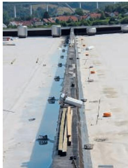
Haupt- und Notentwässerung lassen sich einfach unterscheiden, da die Wehre der Notentwässerung mit oranger Haube einfach zu erkennen sind, die Abläufe der Hauptentwässerung sind silberfarben.
