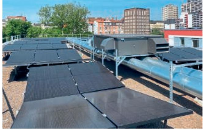
Dank des hochwirksamen Kreuzgegenstrom-Wärmetauschers erzielen die zentralen Lüftungsgeräte Duplex 1500 Multi Eco-N einen Wärmerückgewinnungsgrad von bis zu 93 % und sind damit besonders energieeffizient. Die Ventilatoren sind stufenlos regulierbar.
