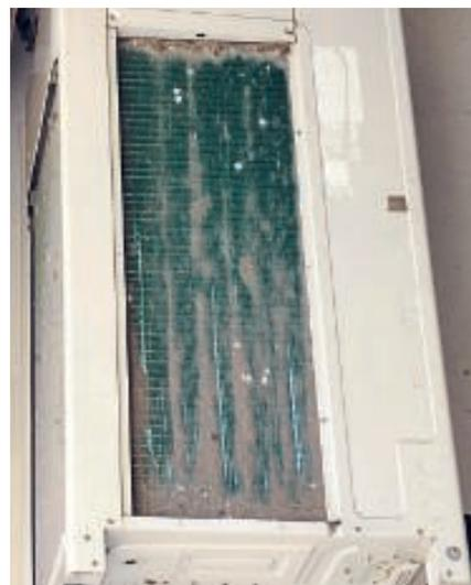
Joachim Dietle, Ziehl-Abegg, nahm einfache Lösungen zur Steigerung der Energieeffizienz wie das Reinigen von verschmutzten Wärmetauschern – im Bild eine Beispielaufnahme – und den Ventilortausch in den Blick.
