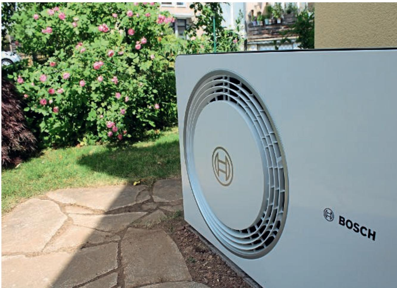
Die moderne Außeneinheit der Luft-/Wasser-Wärmepumpe Compress 6800i AW von Bosch im Vorgarten eines sanierten Einfamilienhauses in Kassel. Die Technik ist auf den Einsatz im Altbau und auf Reihenhaussiedlungen zugeschnitten.
