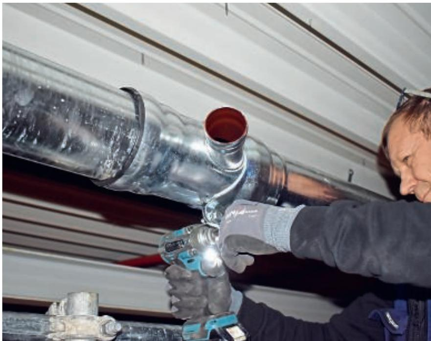
Je zwölf Drainjet-Abläufe (DN 70) werden in Sammelleitungen über die gesamte Hallenlänge gebündelt. Gut zu erkennen ist der Abzweig, der dann von Normann Wiedemeyer an einen Ablauf angeschlossen wird.
