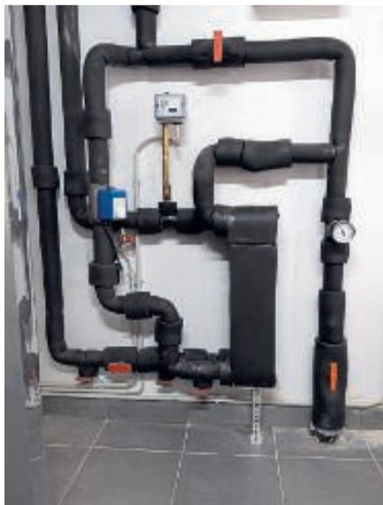
Über eine Zisterne wird Brunnenwasser mit 10 °C für die ganzjährige Nutzung der Wärmepumpen gefördert. Jede Wohneinheit erhält einen Wärmetauscher-Anschluss an die Zisterne.
