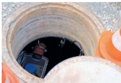
Das Klima-Gründach ist mit einer unterirdischen Zisterne verbunden. Das dort gesammelte Regenwasser wird für die Dachbewässerung und die Spülung der Toiletten genutzt.
