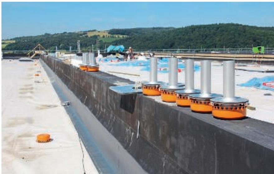
Auf einer Dachfläche von rund 7.800 m<sup>2</sup> wurden 96 Drainjet-Abläufe (DN 70) verbaut.
