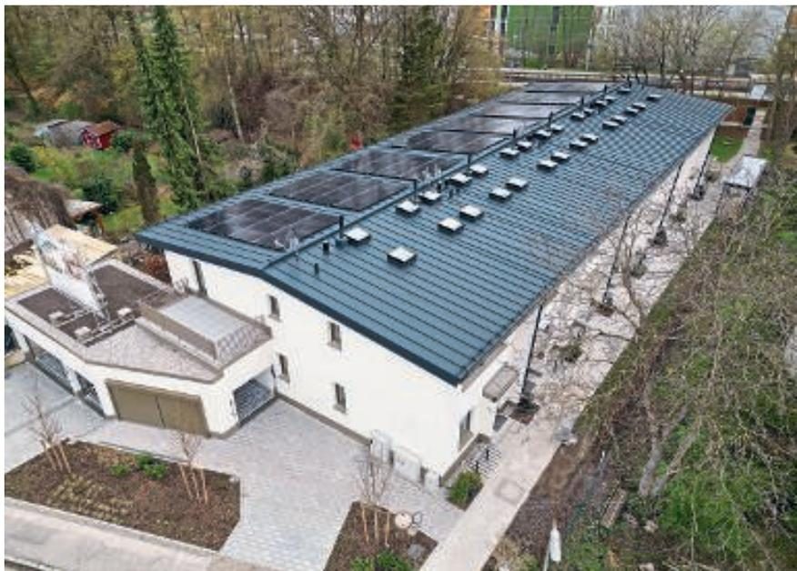
Anstelle der ursprünglich geplanten Gasheizung setzt der Bauträger in den acht Stadthäusern in München-Daglfing auf eine Kombi aus Wärmepumpe, Photovoltaik und Brunnenwasser zur Wärmeversorgung.
