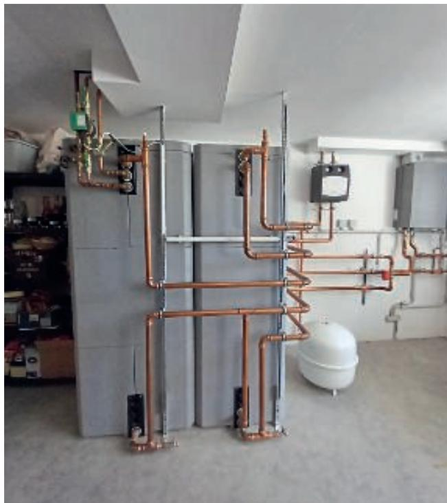
Im Heizungskeller beim Orgelbauer Bosch steht ein Komplettsystem von Roth: Anbindung der Monoblock-Wärmepumpe Thermo Auro F, Thermotank Quadroline-TWW-Speicher 500 l (links) und Pufferspeicher Heizung 300 l (rechts). Die Kupferleitung sind absichtlich ungedämmt, weil sie Demonstrationszwecken dienen.
