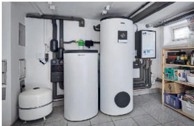
Innen im Keller der Familie befindet sich die Vaillant-Energiezentrale. Nicht im Bild sind zwei Wechselrichter von Kostal und der Stromspeicher von BYD.
