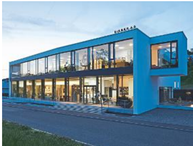
Im Jahr 1996 bezog die Heizungsfachfirma Hieber AG einen Neubau im Gewerbegebiet Weikersheim.
