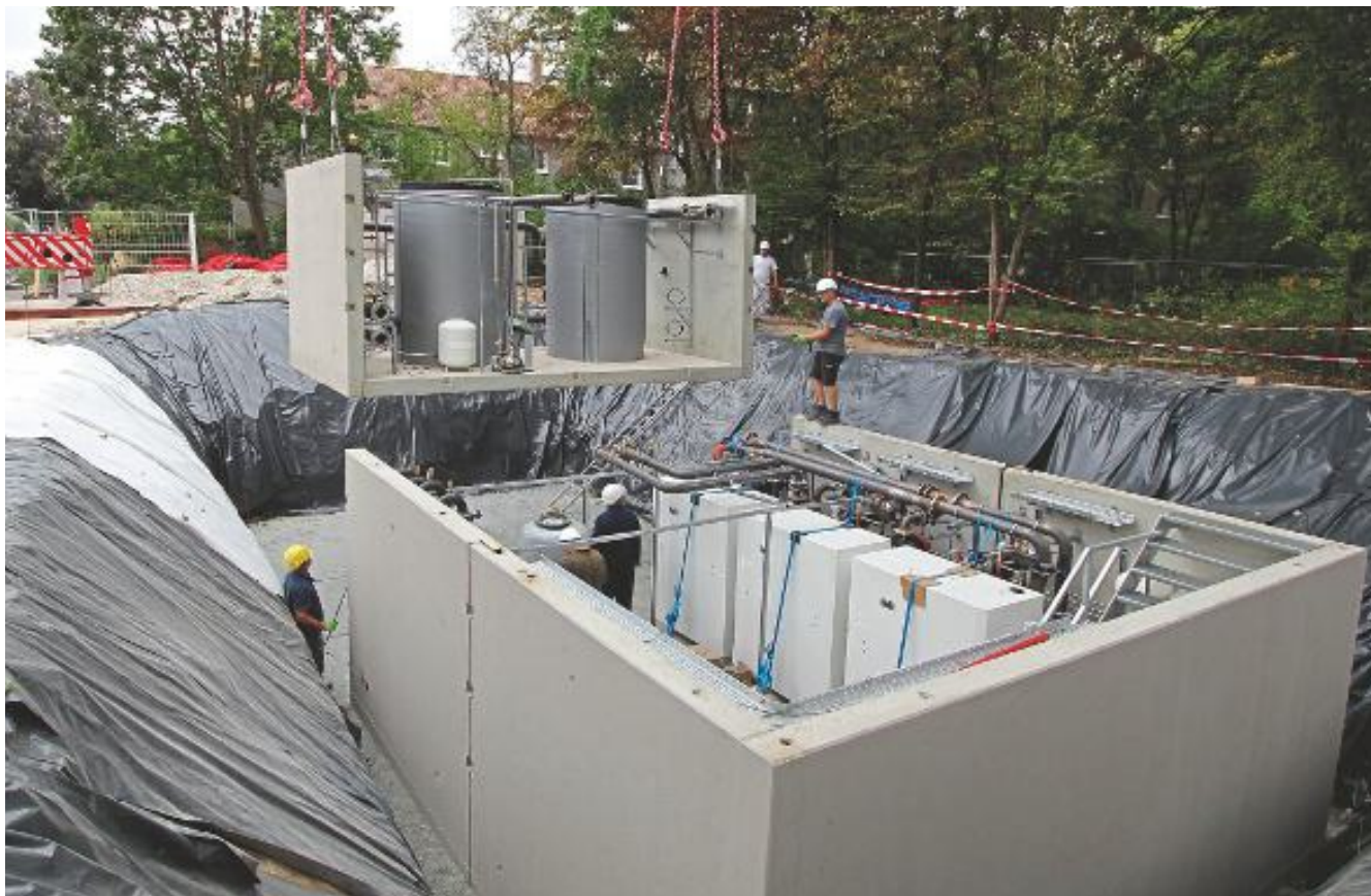
Die vorkonfektionierte Energiezentrale Sistems Ground Cube ist eine unterirdisch versenkbare Hauszentrale in einem Betonkubus, in dem die gesamte Versorgungsinfrastruktur eines Gebäudes gebündelt ist.
