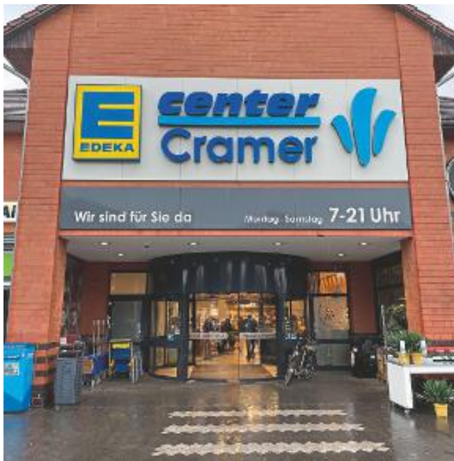
Mit seinem parallel hohen Verbrauch von Wärme und Kälte ist der Lebensmittel-einzelhandel prädestiniert für Wärmerückgewinnungskonzepte.
