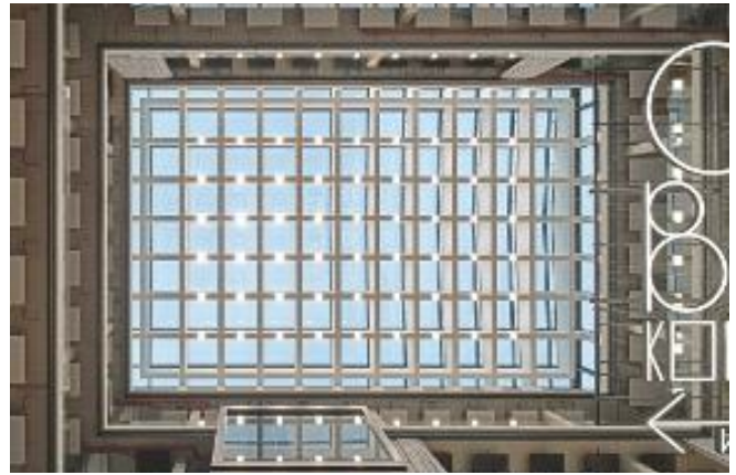
Dank der Sauter-Systeme wird sowohl der glasüberdachte Innenhof als auch die Beleuchtung effizient gesteuert.
