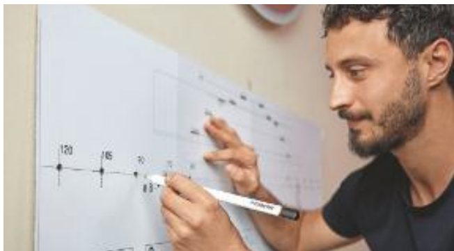
Mit der für alle Mix-&-Match-Serien standardisierten Montageschablone entfällt das Ausmessen der Bohrlöcher an der Wand.
