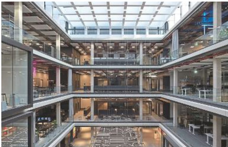
Sauter wurde als Spezialist für Lösungen in Gebäudemanagement und Raumautomation mit der Gebäudetechnik der drei Bürogebäude i5, i6 und i7 beauftragt.
