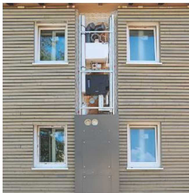
Mit dem Sistemas-Backpacker können Strangsanierungen über die Fassade realisiert werden. Die Wohnungseinheit bündelt Übergabestation, kontrollierte Wohnraumlüftung, Wärmeversorgung sowie Abwasser- und Frischwasserleitungen.
