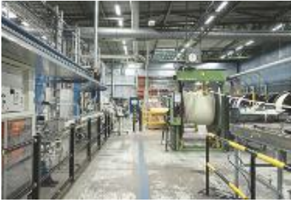
Blick ins Uponor-Werk Virsbo: Hier entstehen PEX-Rohre. Der schwedische Standort produziert nun vollständig klimaneutral.
