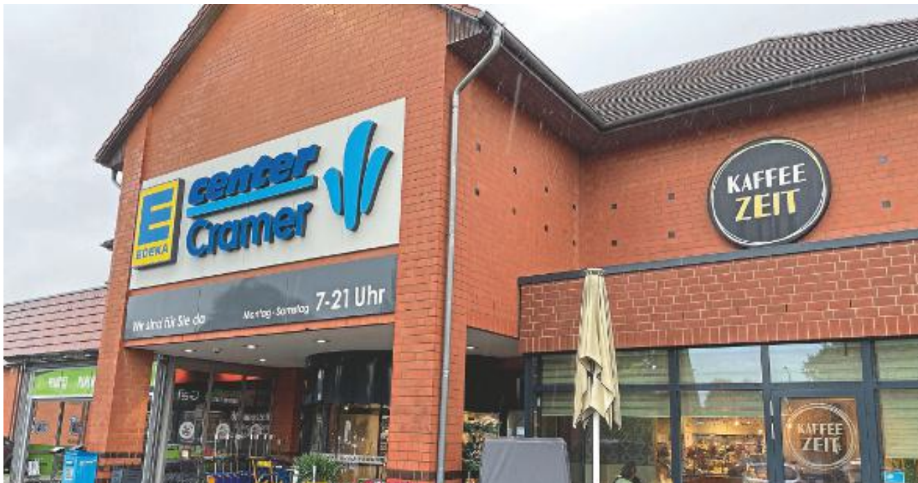
Erfolgreicher Umstieg auf grüne Energie: Im Rahmen eines umfassenden Sanierungsprojekts hat das E-Center Cramer die Kopplung von Kälteproduktion und Abwärmenutzung neu am Standort Großburgwedel etabliert.
