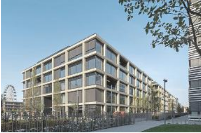
Gebäudeleittechnik von Sauter regelt bedarfsgerecht die Jalousiensteuerung der drei Gebäude im „iCampus im Werksviertel“.
