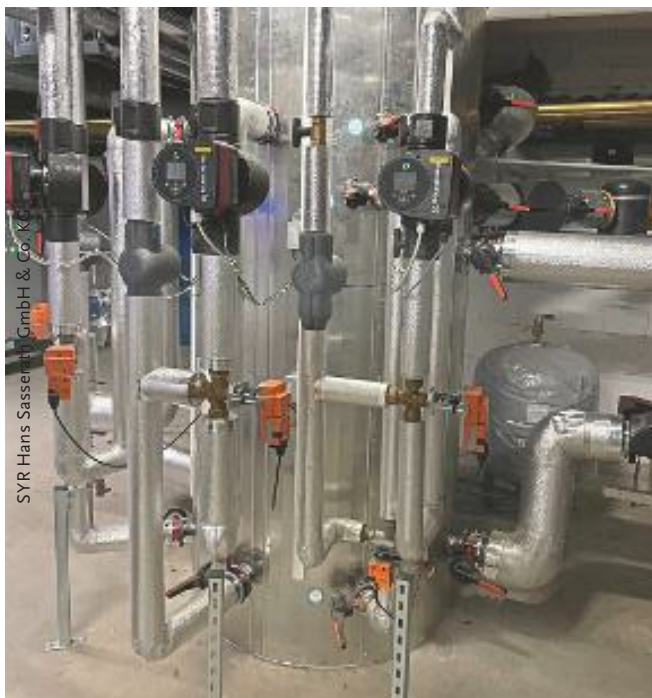
Eine vollständige Volumenstromentkopplung und die maximale Schichtungsqualität schaffen die Voraussetzungen für eine effektive Effizienzausschöpfung in bi- und multivalenten Versorgungsstrukturen.
