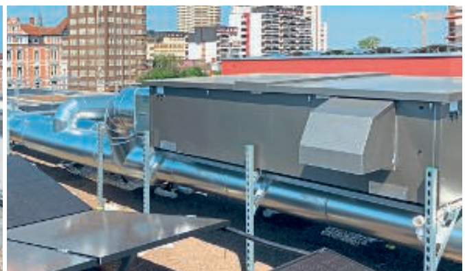
Die zentralen Lüftungsgeräte Duplex 1500 Multi Eco-N von Airflow nutzen einen effizienten Kreuzgegenstrom-Wärmetauscher. So erreichen sie einen Wärmerückgewinnungsgrad von bis zu 93 %. Die Ventilatoren lassen sich stufenlos einstellen.
