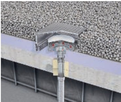
Die Kombination von wasserundurchlässigem Beton und Edelstahl-Durchführungen ermöglicht eine effiziente Ableitung von Regenwasser und schützt darunterliegende Strukturen vor Feuchtigkeitsschäden.
