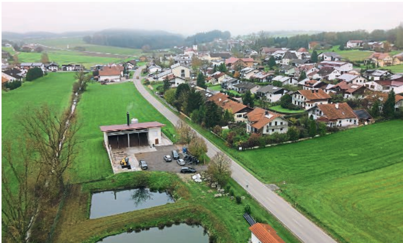
Biomasseheizwerk am Rande der niederbayerischen Gemeinde Geratskirchen versorgt 100 Haushalte mit nachhaltiger Holzwärme aus einem Holzheizwerk.
