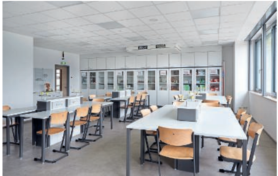
Die besonders leisen Lüftungsgeräte der Duplex-Vent-Serie von Airflow sind ideal für den Einsatz in Schulen. Ihr niedriger Schalldruckpegel sorgt dafür, dass sie kaum auffallen und den Unterricht nicht stören. Die dezentralen Geräte lassen sich einfach nachrüsten und – je nach Modell – zu 1/3, 2/3 oder komplett unauffällig in die Zwischendecke integrieren.
