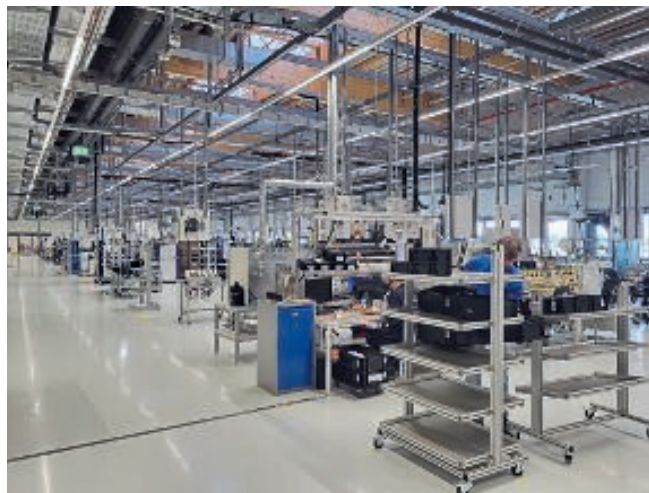
Die einzelnen Maschinen in der Halle werden von der Versorgungsebene aus komplett von oben versorgt.
