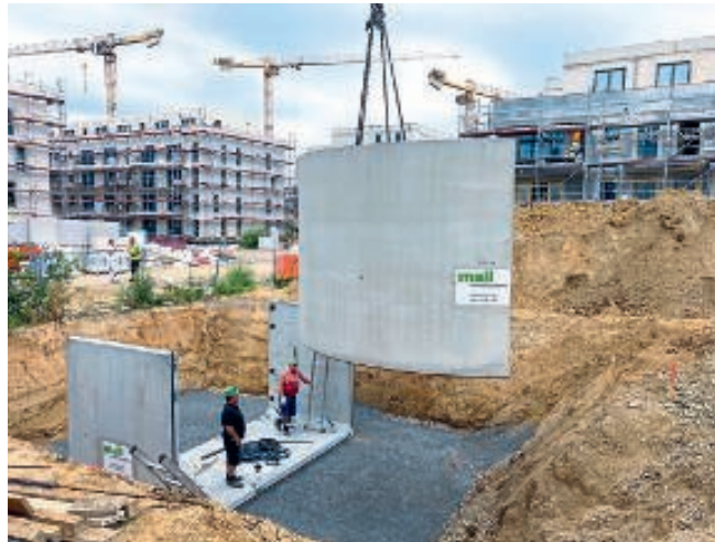
Beispiel 3, Heinersdorf, Bezirk Pankow/Berlin. Löschwasserbehälter in Fertigteilbauweise mit schneller Betriebsbereitschaft, hoher Belastbarkeit.
