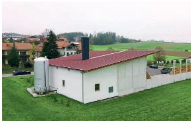
Ein Pufferspeicher mit 32.000 l Inhalt versorgt die Anschlussnehmer in Geratskirchen. Die Anlage ist auf Erweiterung ausgelegt.
