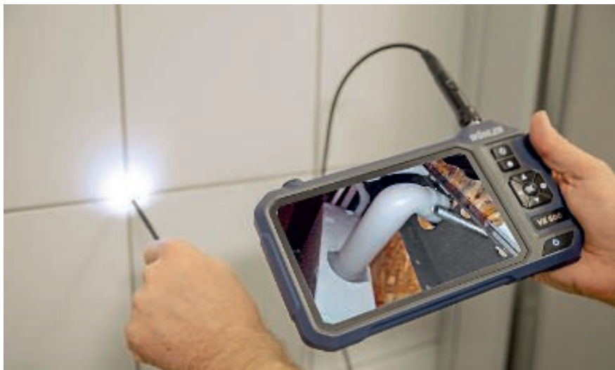
Musste früher noch die Bausubstanz zerstört werden, um sich Stück für Stück der Leckage oder der Verstopfung zu nähern, helfen heute moderne Geräte und Methoden – wie hier die Inspektion mittels Endoskopie.
