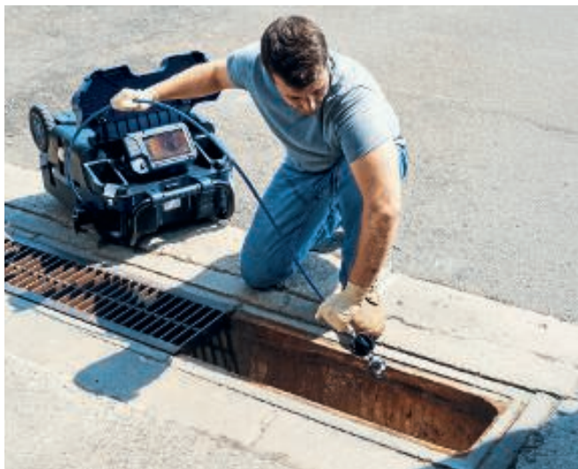
Auch die Inspektionsgeräte sollten einen gewissen Standard erfüllen: Beispielsweise sollte der Kamerakopf schwenkbar und mit einer LED-Beleuchtung ausgestattet sein.
