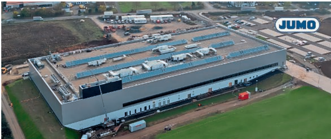
Blick auf die Nordfassade des Sensilo-Werks während der Baumaßnahme.
