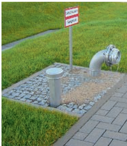
Entnahmestelle gemäß DIN 14230 für unterirdische Mall-Löschwasserbehälter. Die Konstruktion erlaubt je nach Überdeckung PKW- oder LKW-Belastung.
