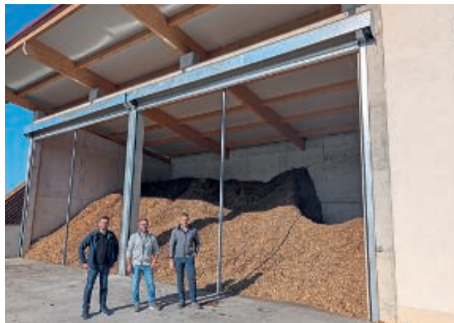
Das Hackschnitzellager besitzt ein Fassungsvermögen von 460 m 3 . Die HDG-Kessel sind auf diesen Brennstoff und dessen unterschiedliche Feuchtegrade ausgelegt und verbrennen ihn emissionsarm.
