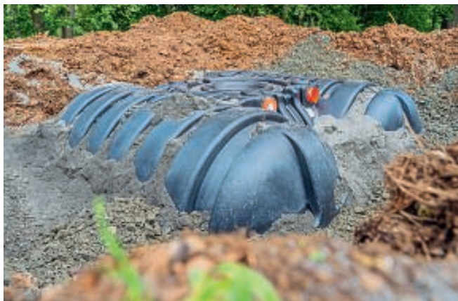
Fehlt die Anbindung ans örtliche Abwassersystem, kommen die Roth-Sammelgruben zum Einsatz. Sie speichern das Abwasser sicher bis zur Absaugung durch den Saugwagen.
